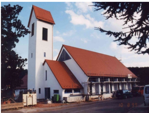
1999, Neubau Pauluskirche, Landstuhl
